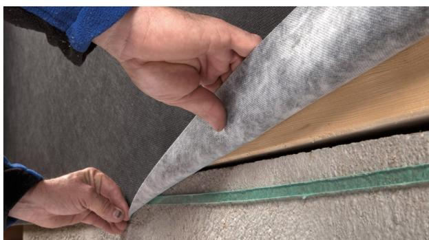
**7. Alternative : raccord à des supports rugueux ou minéraux exemple : dalle béton) avec ORCON MULTIBOND**
