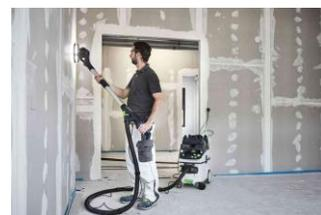
*Ponçage cloison sèche avec éclairage et aspiration. L'aspiration réglable maintient son propre poids au mur ou au plafond,*
