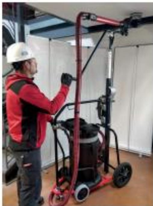
*Solution complète pour le ponçage industriel de plafonds permettant de limiter les contraintes posturales et de port de l'outil.*
