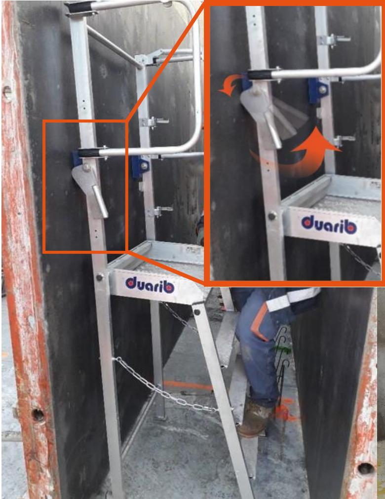
PIRL à faible encombrement permettant un accès **stable** et **sécurisé** entre-banche grâce à deux aimants qui vont se fixer sur la peau coffrante. Son système de repli ingénieux permet de faciliter le passage et son déplacement dans la banche ou entre banches.
