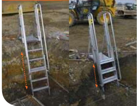
Réglage millimétrique intégré au système anti-basculement du plancher. Pour des profondeurs de 0,80 m à 1,80 m.
