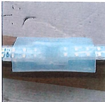
5 - Glisser les gaines thermorétractables sur les raccords et les rétreindre thermiquement
